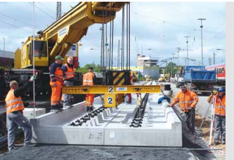
Einbau der Elemente auf Splittbett und Hydraulisch Gebundener Tragschicht (HGT)
