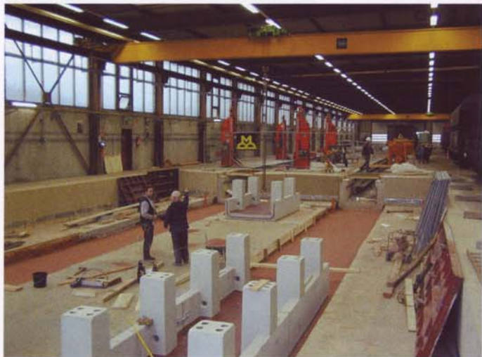
Für die Lok-Instandhaltung wurden in nur viermonatiger Umbauzeit u.a. zwei ergonomisch günstige Arbeitsplätze mit aufgeständerten Gleisen für Schlosser- und Elektroarbeiten erstellt
