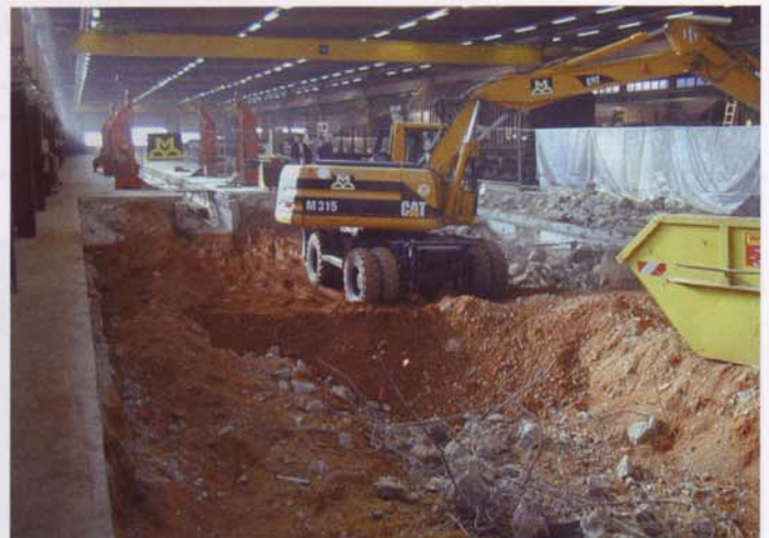
Bestandteil der Umbaumaßnahme war der Rückbau der Gruben in Teilbereichen der Gleise 135 und 136 sowie der Rückbau der Bodenplatte und das Absenken des Bodenniveaus
