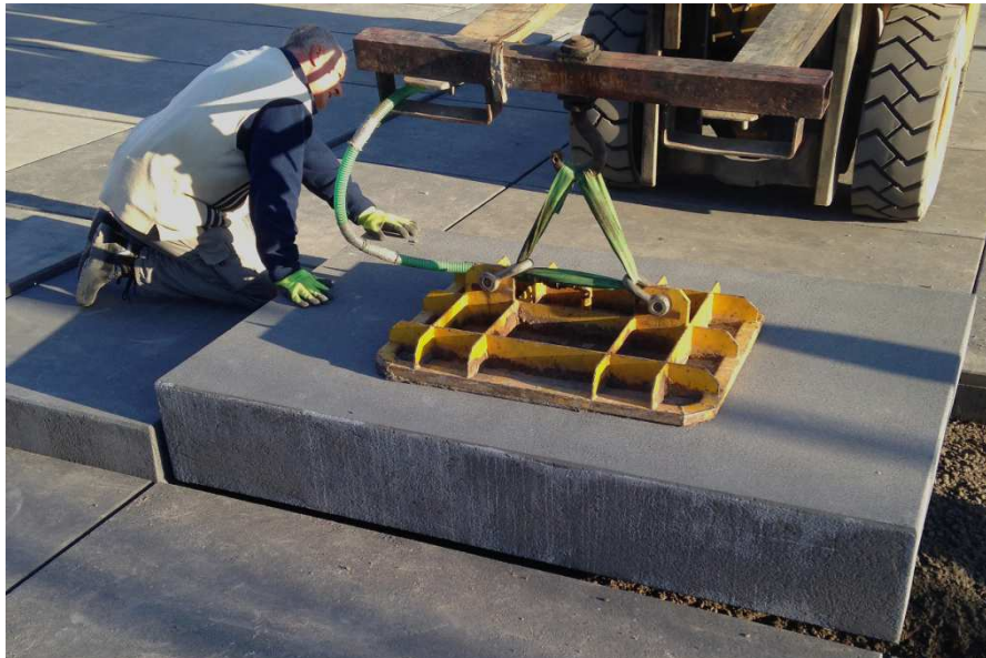
Bild 5: Verlegung mit Vakuumgerät
