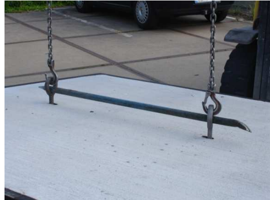
Bild 4: Sicherung der Hubschlüssel
